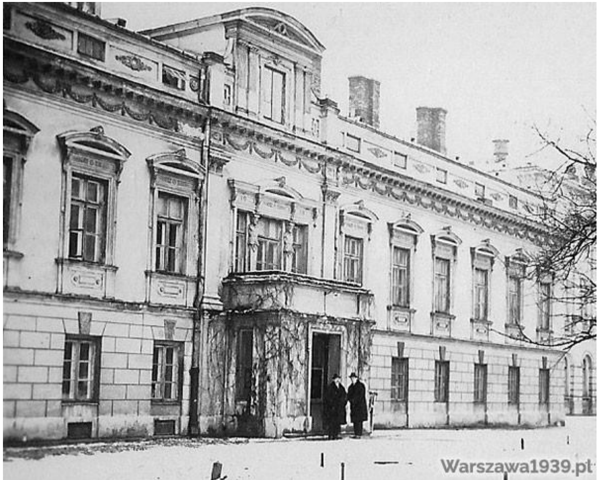
Fot. Krakowskie Przedmieście 26/28. Lata 1926-28. – ze zbiorów Pawła Starewicza. Budynek zbudowany pomiędzy 1816-31.
